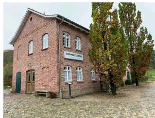
Tür zum Gebäude M6
