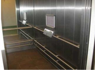
Aufzugskabine und die horizontal angeordneten Bedienelemente
