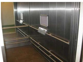
Aufzugskabine und die horizontal angeordneten Bedienelemente
