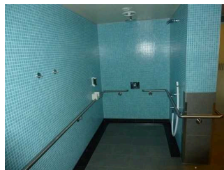
Zu sehen ist der Duschbereich bei den Saunen.
