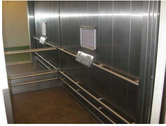
Aufzugskabine und die horizontal angeordneten Bedienelemente
