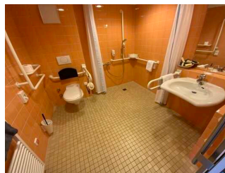
Sanitärraum im Zimmer 352
