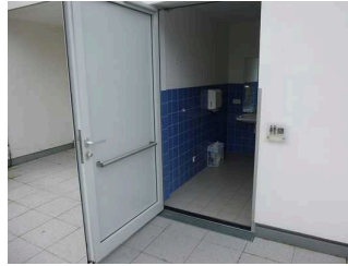
Tür zum WC auf der Dachterrasse.
