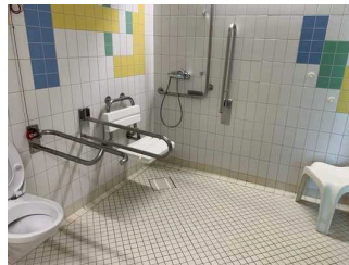
WC Dusche im Umkleidebereich
