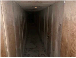
Wege im Stollen
