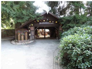
Eingangsbereich zur Kunstwerkhalle
