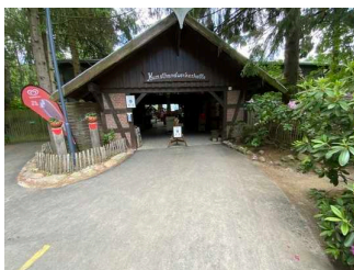
Eingangsbereich zur Kunstwerkhalle
