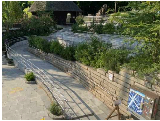
Rampe außen zum Wildpark–Restaurant und Bahnhof
