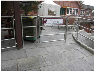
Eingangstor von der Rampe auf die Terrasse des Restaurants
