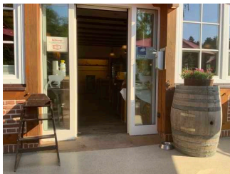
Tür zum Restaurantbereich von der Terrasse kommend
