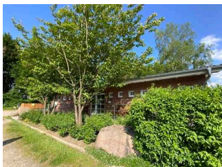
WC, Dusche, Waschraum
