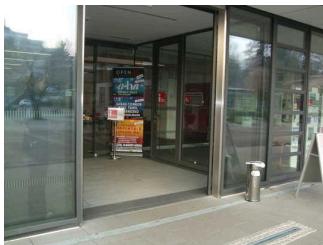
Blick auf den Haupteingang Kurhaus mit Eingangstür (rechts) zur TI
