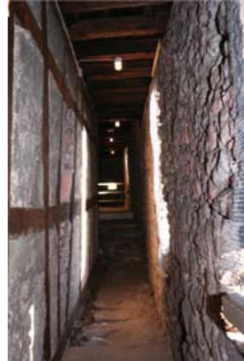
Der ehemalige Wehgang zwischen Stadtmauer und Fachwerkwand der Zehntscheuern ist bis heute begehbar.
