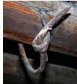
Wieden an den Balken im Dachstuhl dienten zur Aufhängung von Häuten und Ähnlichem
