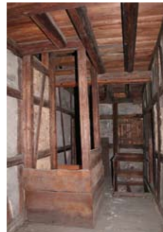
Der erhalten gebliebene Lastenaufzug, der vom Erdgeschoss bis zum Dachfirst der Scheuer Nr. 9 reicht
