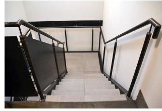
Treppenhaus im Gästehaus
