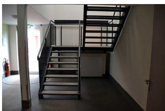
Treppenhaus im Gästehaus
