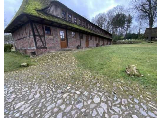
Weg vom Parkplatz zum Zimmer 17
