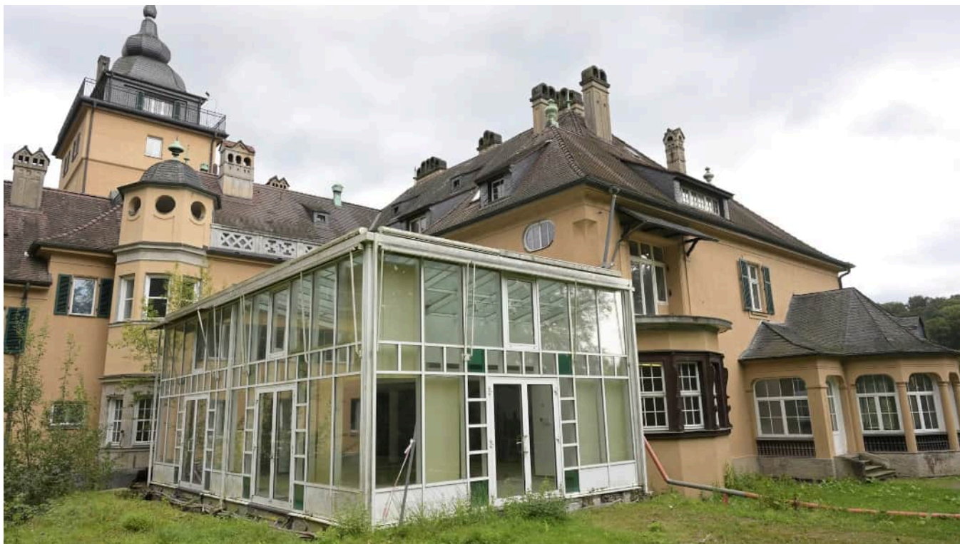
Noch gibt es einige Baustellen am Schlosshotel Lerbach.
