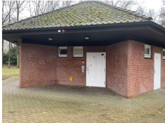
Öffentliches WC am Parkplatz P2
