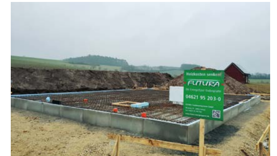
Herstellung der Bodenplatte im Dezember 2021
