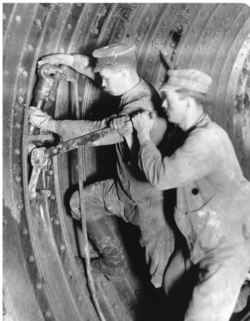
Arbeiter im Kanaltunnel, 1912 Workers in the canal tunnel, 1912
