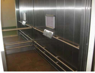
Aufzugskabine und die horizontal angeordneten Bedienelemente
