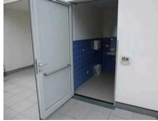
Tür zum WC auf der Dachterrasse.
