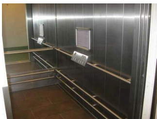
Aufzugskabine und die horizontal angeordneten Bedienelemente
