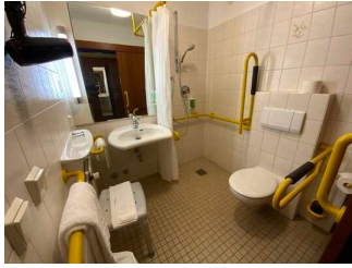
Sanitärraum im Zimmer 203
