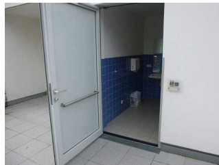
Tür zum WC auf der Dachterrasse.
