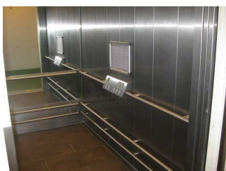
Aufzugskabine und die horizontal angeordneten Bedienelemente
