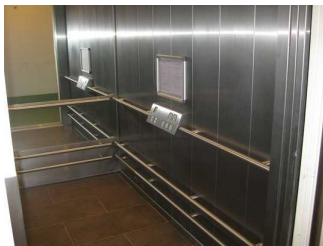
Aufzugskabine und die horizontal angeordneten Bedienelemente
