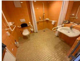
Sanitärraum im Zimmer 352
