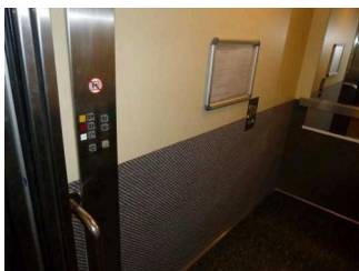
Zu sehen ist das Bedientableau im Aufzug.
