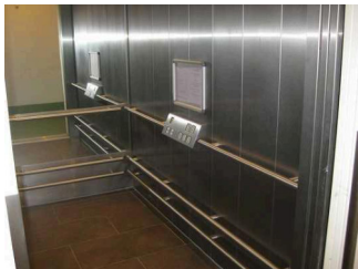
Aufzugkabine und die horizontal angeordneten Bedienelemente
