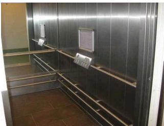
Aufzugskabine und die horizontal angeordneten Bedienelemente
