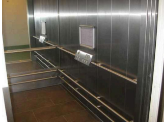
Aufzugskabine und die horizontal angeordneten Bedienelemente
