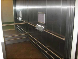
Aufzugskabine und die horizontal angeordneten Bedienelemente
