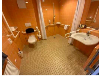
Sanitärraum im Zimmer 352
