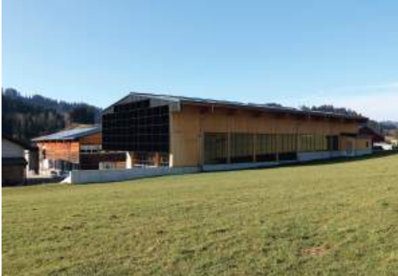
Die 2025 fertiggestellte Produktionshalle III mit Photovoltaikanlagen.
