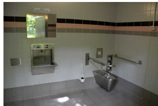
Öffentliches Behinderten WC in Steinhude
