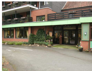
Windfang mit 2 Türen am Haupteingang Hotel
