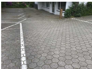
Weg vom Parkplatz zum Nebeneingang
