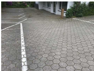
Weg vom Parkplatz zum Nebeneingang
