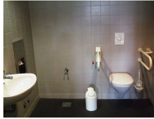
gekennzeichnetes WC Restaurant
