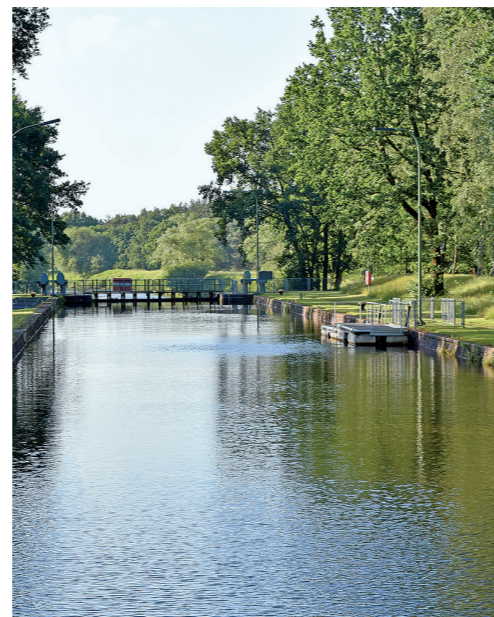
Schleuse in Oldau © Blattwerker.de
