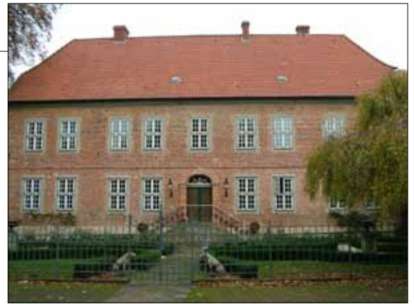
➡ Hinweis und Foto Ehemaliges Fürstenhaus Ebstorf am Domänenplatz. Das Mitte des 18. Jahrhunderts errichtete Gebäude war später auch Wohnhaus des Domänenpächters.
