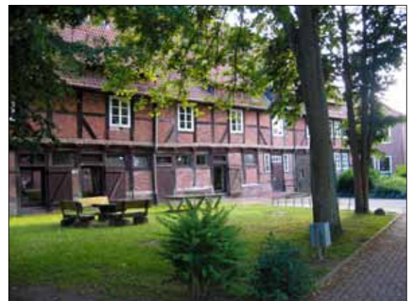
➡ Hinweis und Fotos Der ehemalige Zinskornspeicher von 1622 beherbergt heute den Kindergarten und das Mehrgenerationenhaus.
