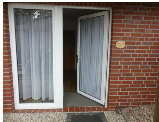
Tür vom Eingangs- Bereich der FW
