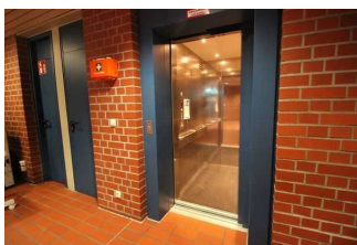
Tür im Erdgeschoß in den Aufzug
