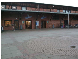
Weg außen vom Parkpatz zum Parkautomaten
